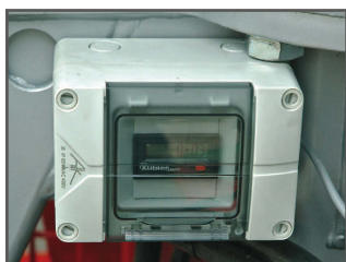
Stundenzähler FK mit Strömungsschalter
